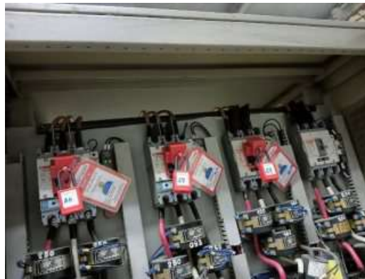
รูปที่ 2-54 ใส่กุญแจวาล์ว สวิตช์และติดป้ายแจ้ง (Lock out-Tag out)
